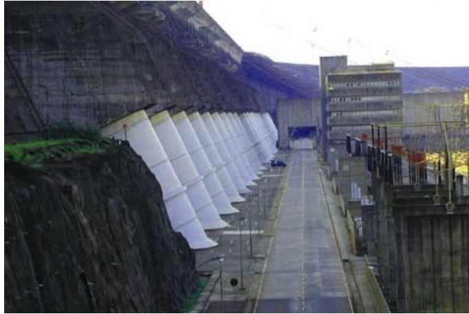
Abb. 14 Staumauer mit den weissen Druckrohren (Quelle: www.portalfoz.com.br )
